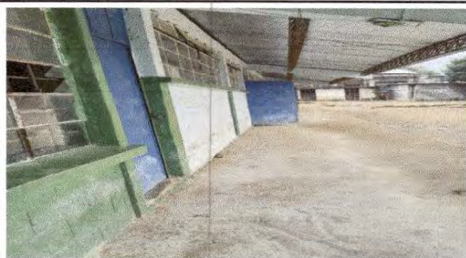
Foto 7: Pintura de muro Exteriores e interiores
