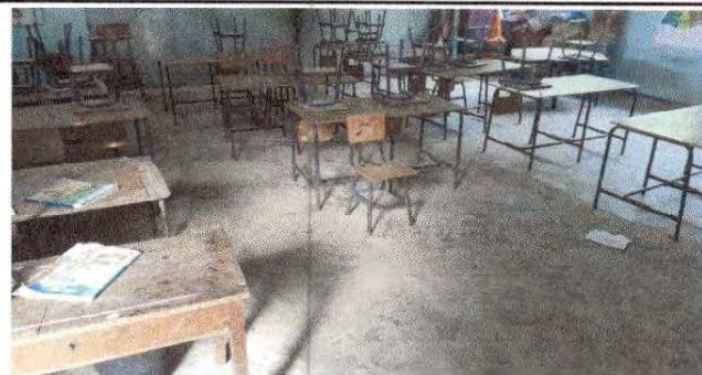
Foto 6: Sustitucion de piso ceramico
