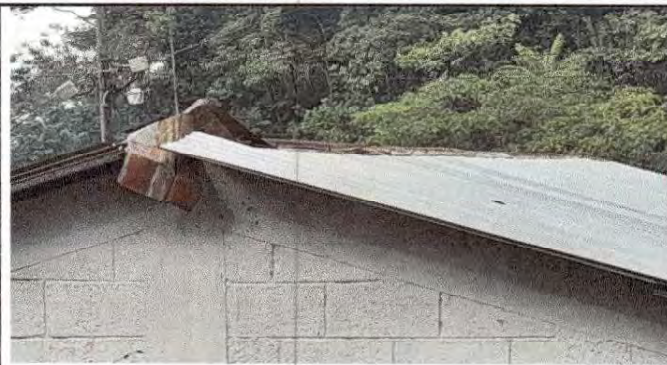
Foto 2: Sustitución de capote o de lamina para lamina troquelada
