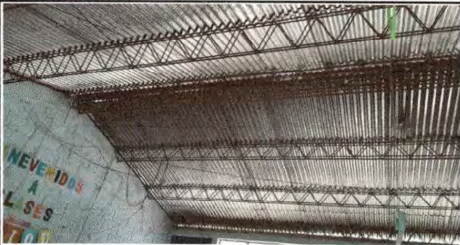
Foto 4: Sustitución de estructuras de soporte de metal, por metal
