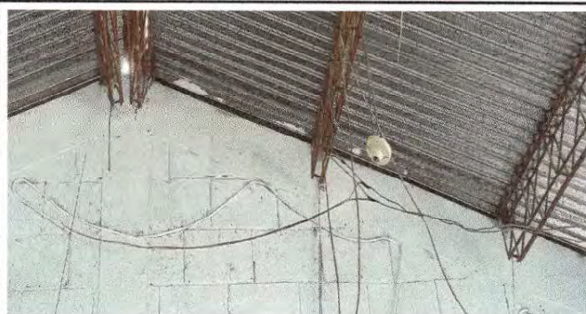
Foto 8: Instalacion de unidades fuerza (focos, tomacorriente, interruptores, flipones) incluye cable electrico
