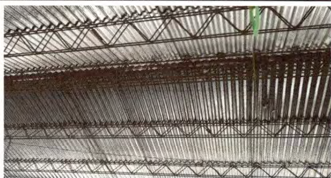
Foto 3: Sustitucion elemento de fijacion
