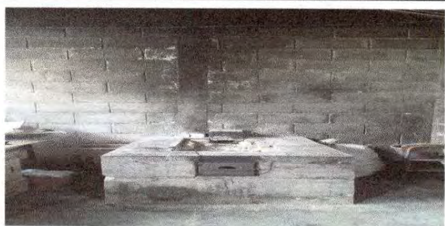
Foto 9: Sustitucion de estufa rural (completa) incluye chimenea y plancha de metal
