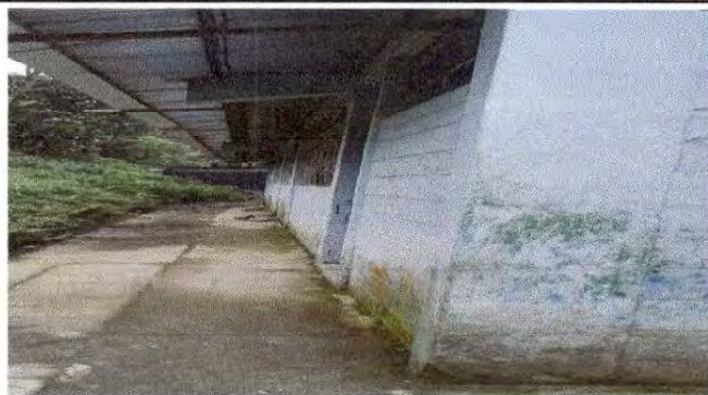
Foto 7: Pintura de muro Exteriores e interiores
